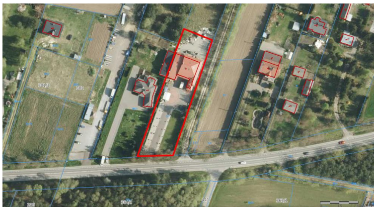
Zał. 1.5a. Teren położony przy ul. Lipowej, po zachodniej stronie obwodnicy Lubartowa. Na terenie tym wprowadza się zmianę przeznaczenia z funkcji siedliskowej (MR) na funkcję mieszkaniowo-usługową.
