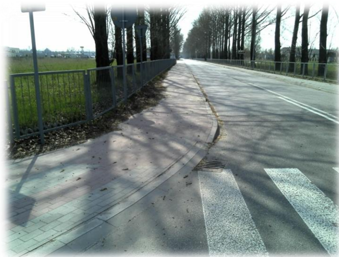
Foto.7/15. DG 103407 L (ul. Gazowa) (w kierunku południowym) Źródło: archiwum M&G
