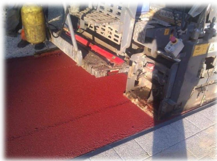
Foto.42. Przykład technologii wykonania dwukierunkowej drogi dla rowerów w terenie zabudowanym z nawierzchni asfaltowej kolorowej (czerwonej – bezpiecznej i widocznej)).
