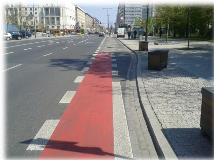
Foto.32. Pas ruchu dla rowerów wylot do zatoki autobusowej. Źródło: archiwum własne M&G
