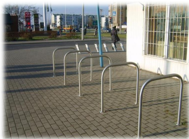
Foto.44. Prawidłowa konstrukcja stojaków rowerowych. Źródło: archiwum M&G
