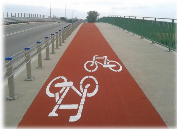
Foto.27. Ścieżka rowerowa dwukierunkowa na nowym obiekcie mostowym. Źródło: archiwum własne M&G
