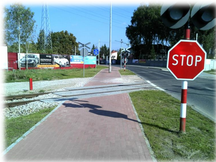
Foto.26. Przejazd dla rowerów przez torowisko w terenie zabudowanym, nawierzchnia asfaltowa. Źródło: archiwum własne M&G
