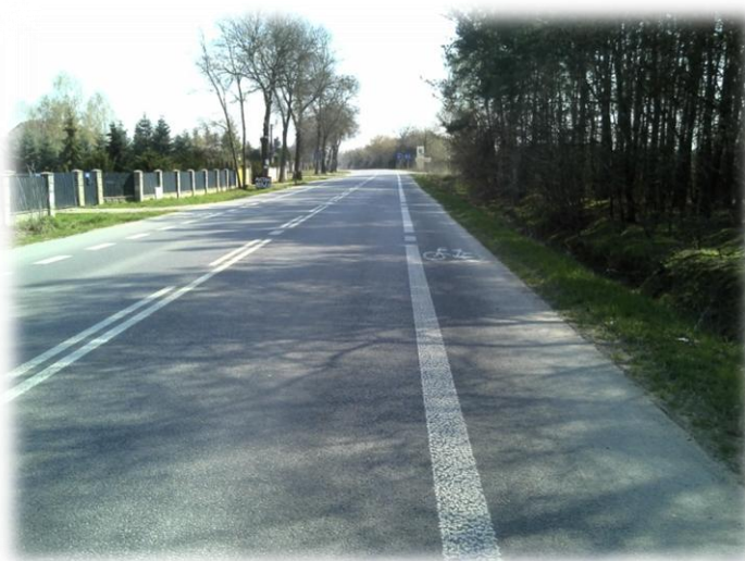
Foto.1/1. DP 1528 L (ul. Lipowa) (w kierunku wschodnim)
