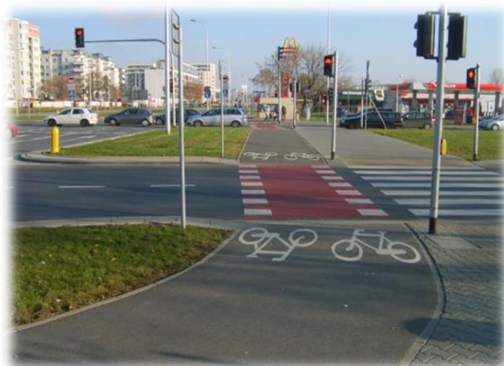
Foto.18. Przejazd dla rowerów przez skrzyżowanie z sygnalizacją świetlną. Źródło: archiwum M&G
