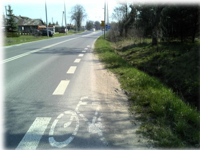
Foto.2/3. DP 1528 L (ul. Lipowa) (w kierunku wschodnim)
