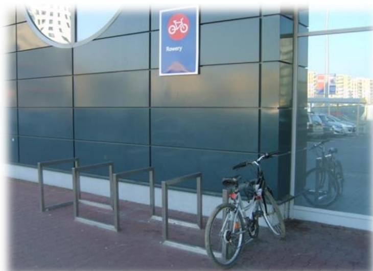
Foto.46. Prawidłowa konstrukcja stojaków rowerowych. Źródło: archiwum M&G
