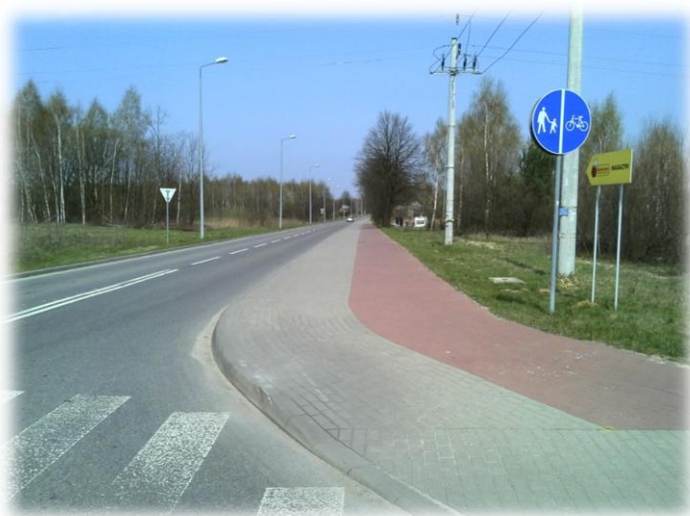
Foto.10/19. DG 103407 L (ul. Gazowa) (w kierunku północnym)
