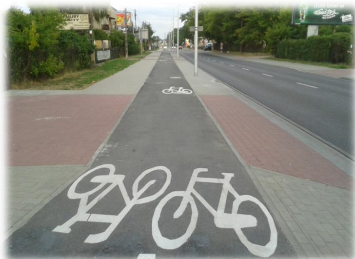
Foto.22. Ścieżka rowerowa dwukierunkowa (przejazdy poprzeczne do posesji na jednym poziomie) w terenie zabudowanym, nawierzchnia asfaltowa. Źródło: archiwum własne M&G
