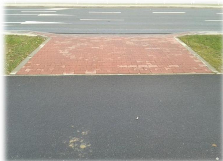
Foto.24. Zjazd (jezdnia – ścieżka) z jezdni przez ścieżkę rowerową (na jednym poziomie). Źródło: archiwum M&G.
