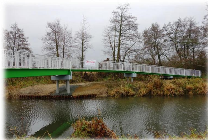
Foto.29. Kładka pieszo-rowerowa nad rzeką w terenie niezabudowanym wykonana z kompozytów. Źródło: archiwum własne M&G
