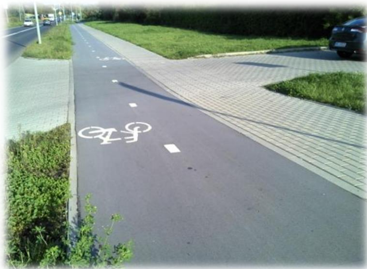
Foto.43. Przykład wykonania dwukierunkowej drogi dla rowerów (ciąg pieszo – rowerowy) w terenie zabudowanym z nawierzchni betonowej. Źródło: archiwum M&G.
