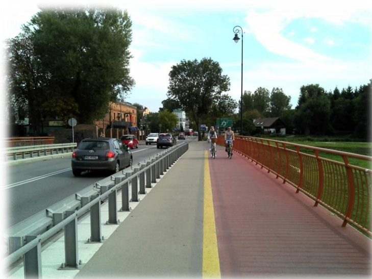
Foto.28. Ścieżka rowerowa dwukierunkowa w terenie zabudowanym na zmodernizowanym obiekcie mostowym. Źródło: archiwum własne M&G
