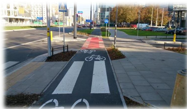
Foto.19. Przejazd dla rowerów przez skrzyżowanie bez sygnalizacji świetlnej. Źródło: archiwum M&G
