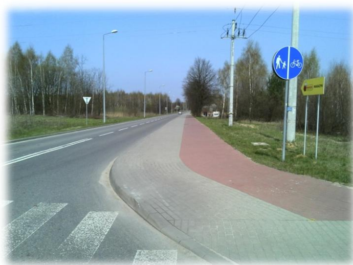
Foto.19. DG 103407 L (ul. Gazowa) (w kierunku północnym)
