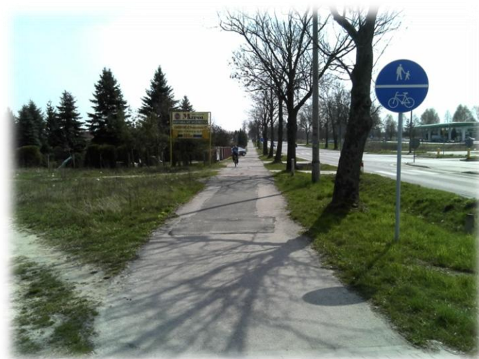
Foto.28. DG 112607 L, ul. Lubelska (w kierunku południowym)
