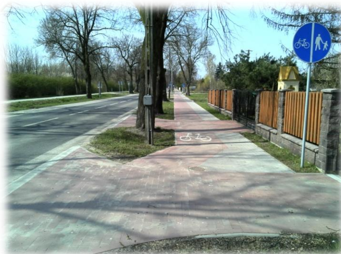
Foto.13. DP 1528 L (ul. Lipowa) (w kierunku zachodnim)
