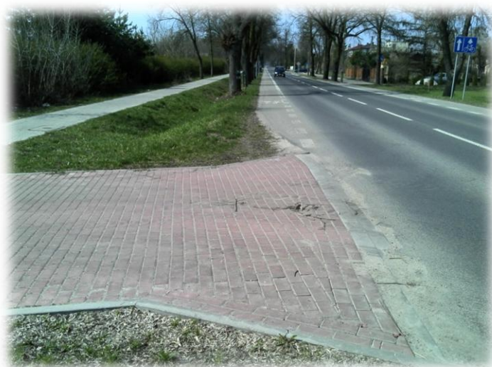
Foto.11. DP 1528 L (ul. Lipowa) (w kierunku zachodnim)
