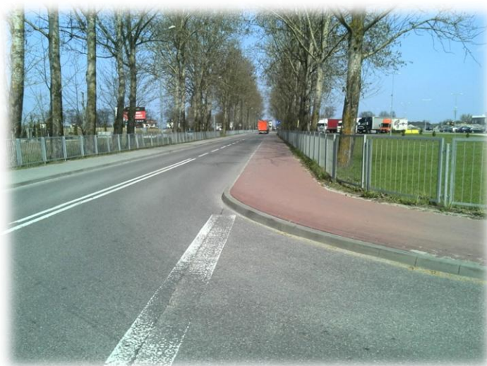
Foto.17. DG 103407 L (ul. Gazowa) (w kierunku północnym)
