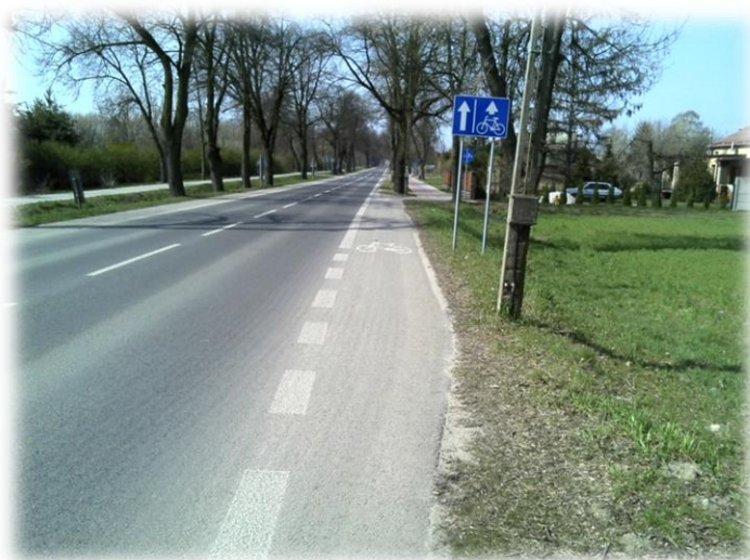
Foto.10. DP 1528 L (ul. Lipowa) (w kierunku zachodnim)
