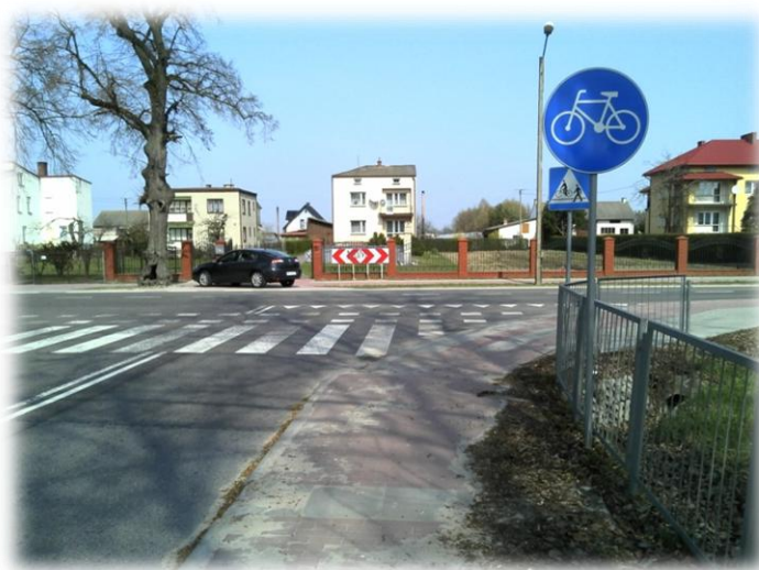
Foto.16. DG 103407 L (ul. Gazowa) (w kierunku północnym)
