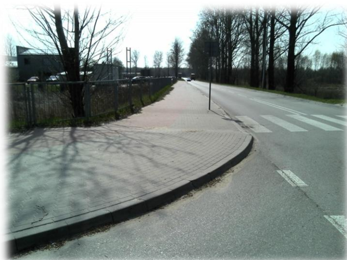
Foto.18. DG 103407 L (ul. Gazowa) (w kierunku południowym)
