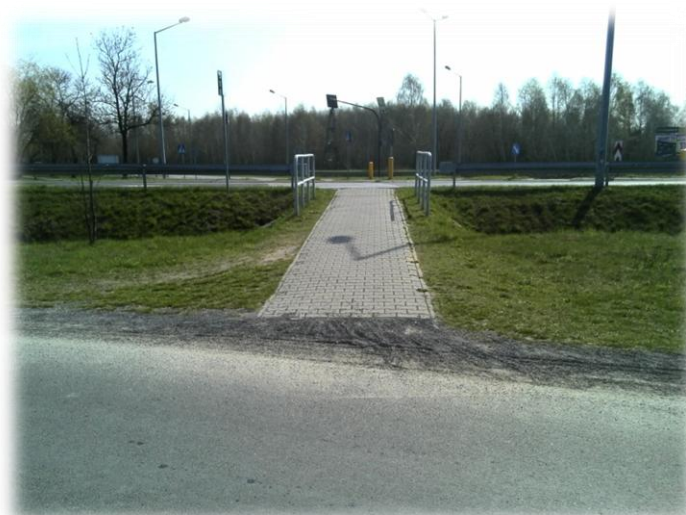
Foto.4. Droga serwisowa wzdłuż DK 19 (w kierunku wschodnim)
